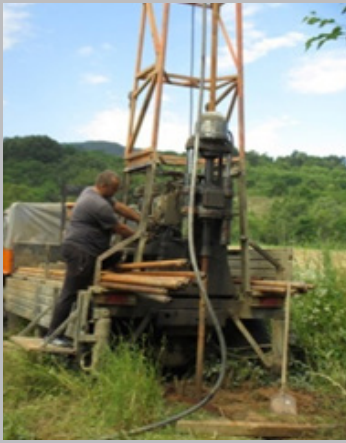
Sl. 1. Iskopavanje zajedničkog bunara (EHO)
