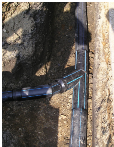
Sl. 7. Spajanje toka vakuumske glavne mreže (Šanta i Farby, 2006)
