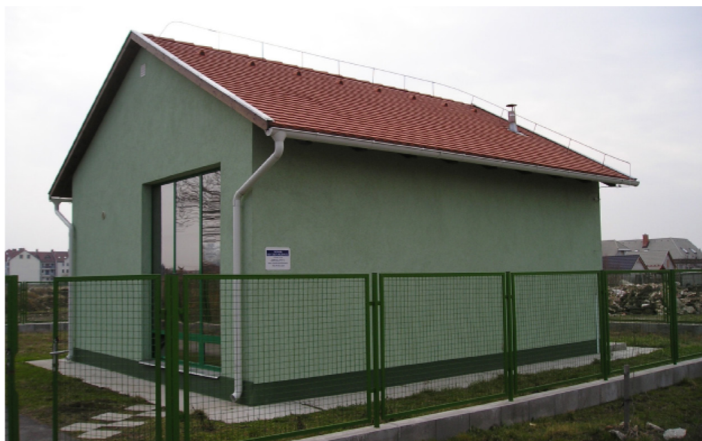
Sl. 10. Ukopana vakuumska stanica sa nadzemnim delom (Šanta i Farby, 2006)
