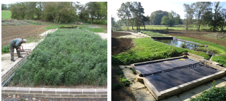
Sl. 5. i 6. Rid-bed sistem tretman otpadnih voda pomoću akvatičnih biljaka
