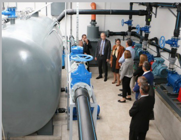
Sl. 11. Hidrotehnička oprema vakuumska stanica u naselju Mali Krivak, Smederevo (MGSI)
