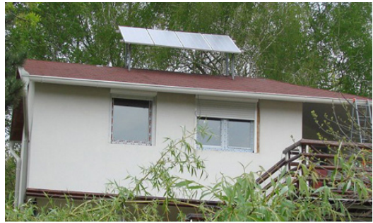
Sl. 14. Solarni paneli na kući za domor na Adi Međici, Beograd
